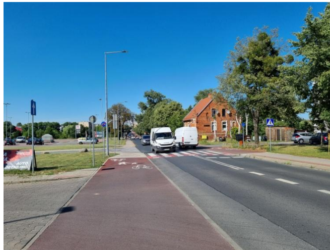
Przejazd dla rowerzystów i przejście dla pieszych oznakowane znakiem pionowym D-6a (przejazd dla rowerzystów) zamiast D-6b (przejście dla pieszych i przejazd dla rowerzystów). Ul. Lipowa w Pleszewie.
